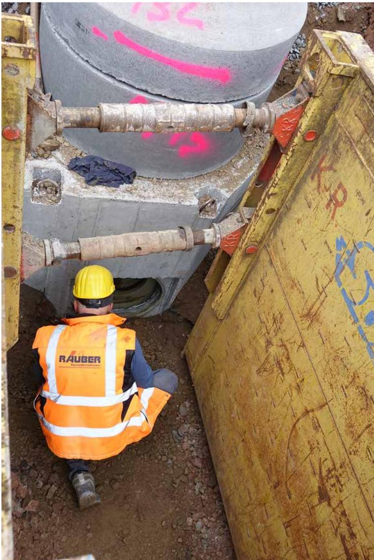
Vor dem Zusammenfügen werden sowohl das PVC-Spitzenende als auch die Dichtung auf dem Betonspitzenende sowie die Muffen von Beton- und Kunststoffrohr oder wie hier die Schachtmuffe mit Gleitmittel eingeschmiert.
