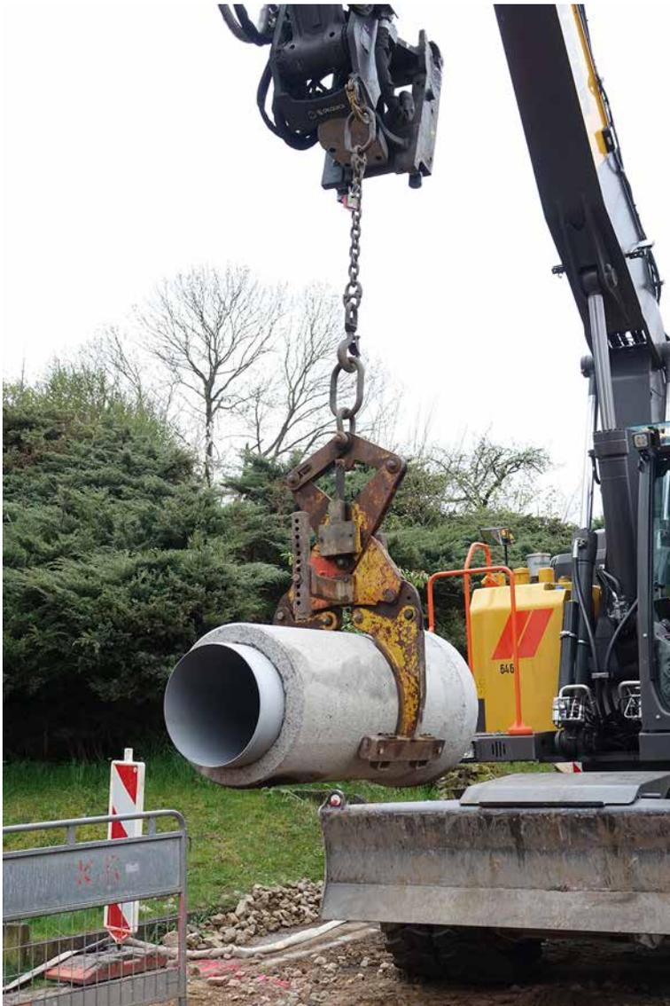
Für den neuen, rund 390 m langen Mischwasserkanal kommen FABEKUN®-Kanalrohre DN 500 zum Einsatz.
