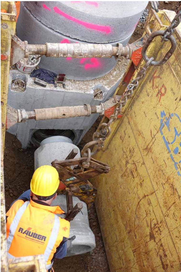
Fachgerechtes Ablassen und Einbau des Kanalrohres mit Hebezeug.
