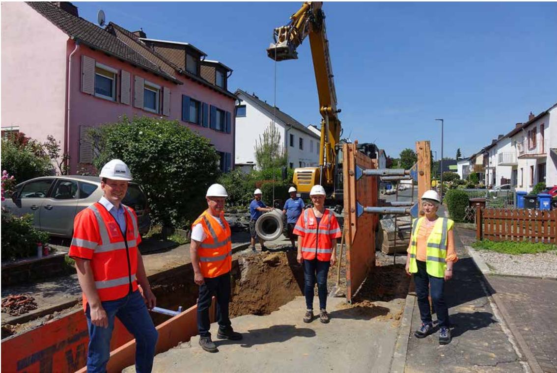
Baubesprechung vor Ort: Helga Schlosser, Stadtwerke Bad Camberg, Kathleen Prüter, Gebr. Fasel Betonwerk GmbH, Bernd Aulmann, Stadtwerke Bad Camberg, und Fabian Fasel, Geschäftsführer Gebr. Fasel Betonwerk GmbH (v.r.n.l.).
