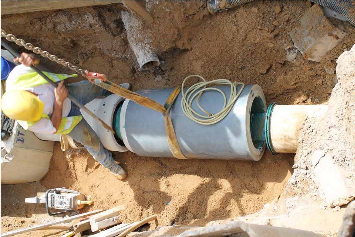
Einheben des Teleskoprohres in eine beschädigte Haltung.
