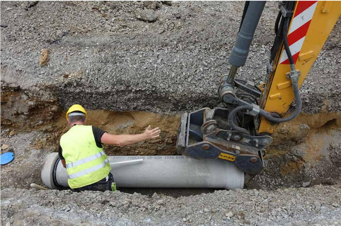
Die Rohre werden im Graben zusammengeschoben.
