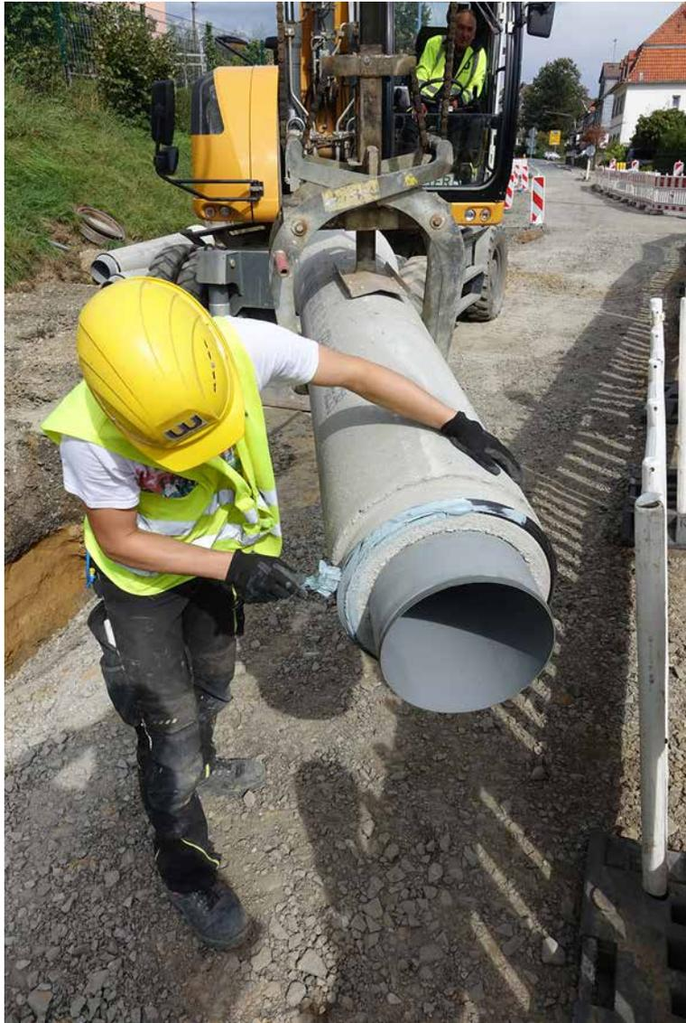
Fachgerechtes Einfetten des Spitzendes vor dem Einbau des Kanalrohres.
