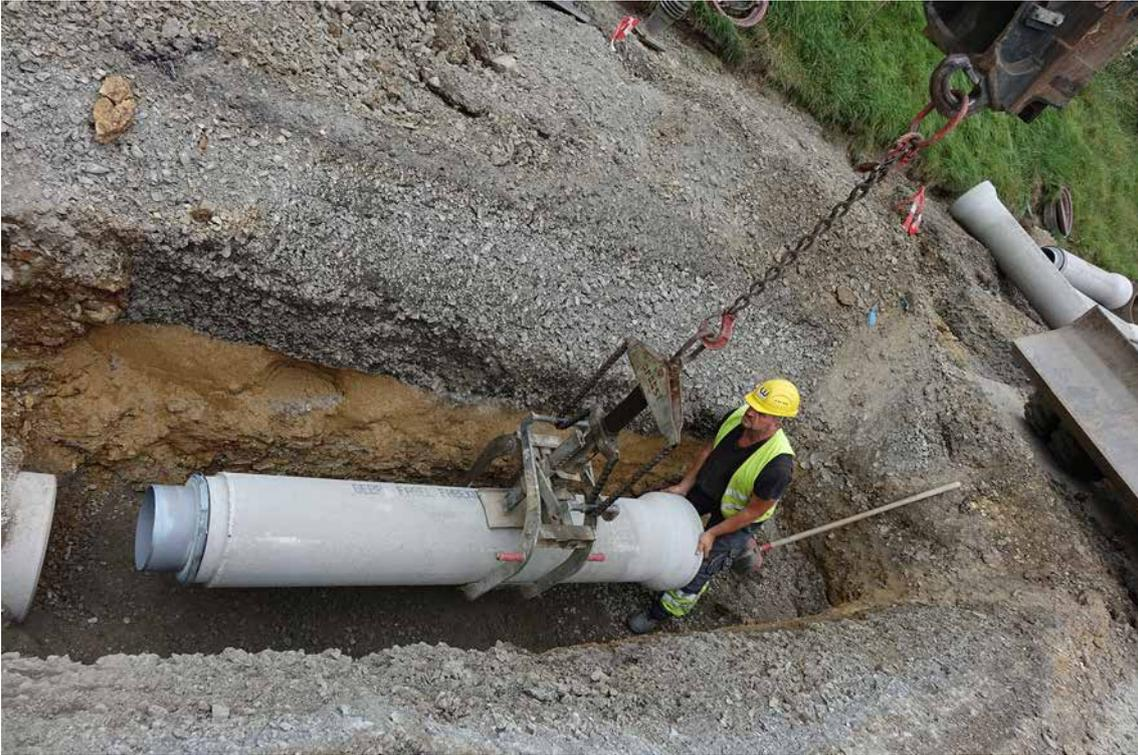
Einheben der Rohre in die Baugrube.
