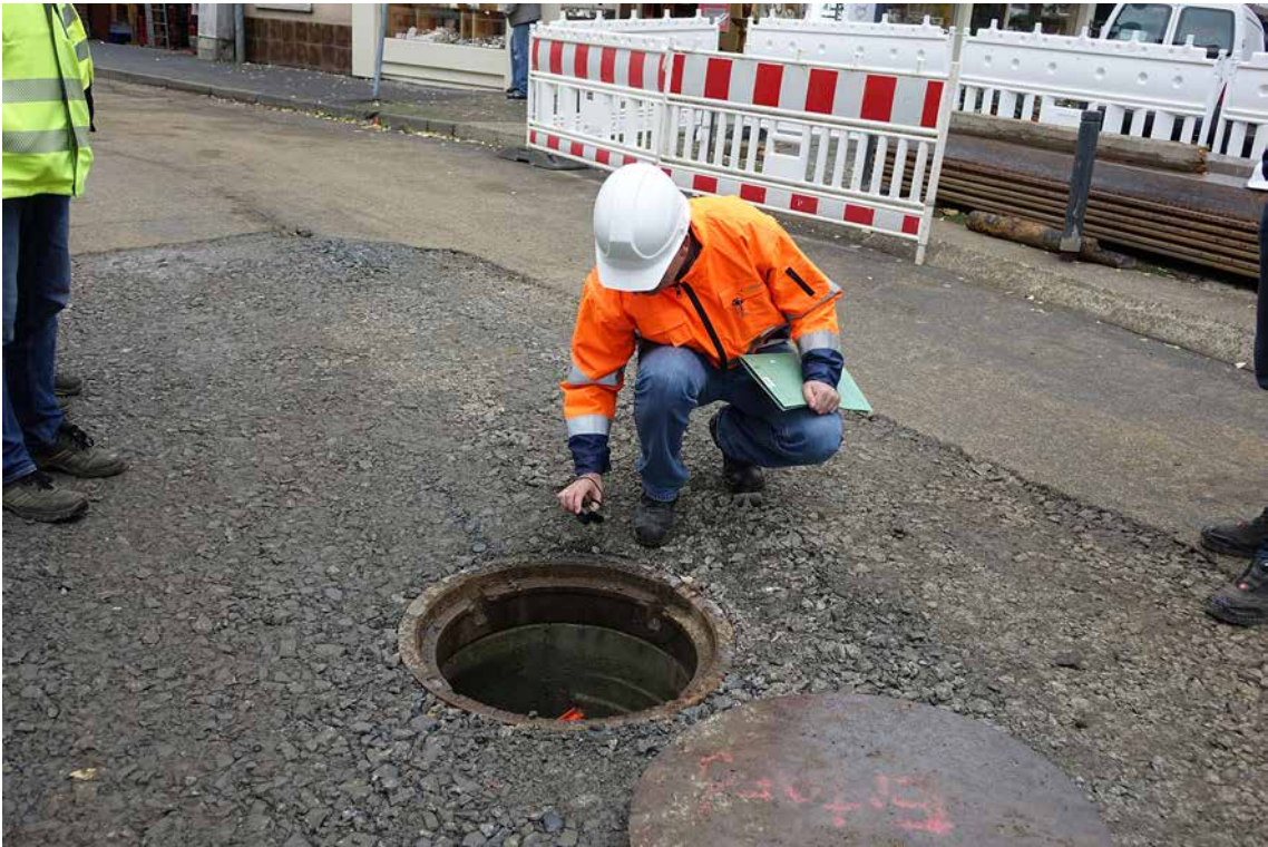
Alexander Schlein kontrolliert den Einbau des Tangentialschachtes.
